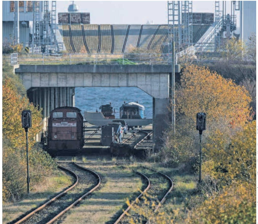
Gleisstrecken der russischen Breitspur im Hafen Mukran auf Rügen, jetzt Teil der Seidenstraßeninitiative
